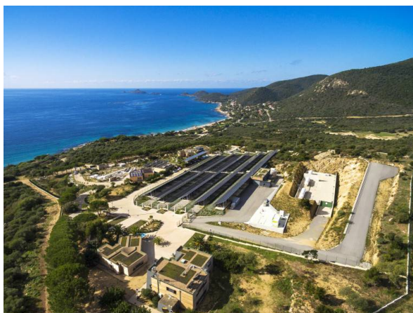
Figure 5 - Démonstrateur MYRTE (Mission hYdrogène Renouvelable pour l'inTégration au réseau Electrique) en Corse
