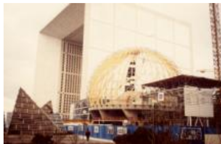
Figure 32. Dôme en cours de construction réalisé en bois lamellé-collé.
