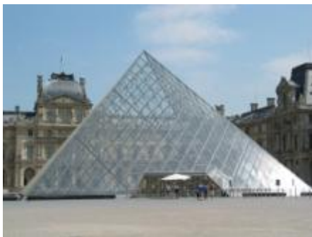
Figure 20. Vitrage de la Pyramide du Louvre jointoyé avec un mastic silicone.
